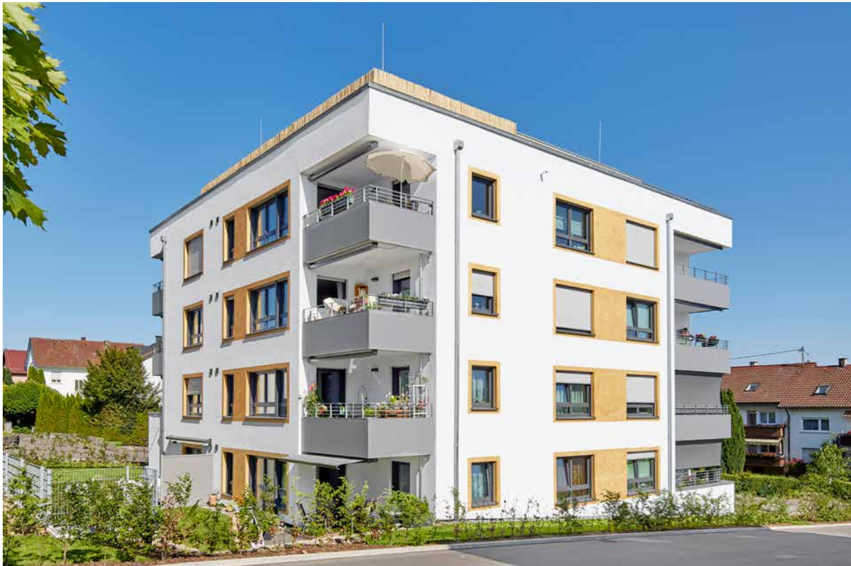
01 - Copertina Nuovo edificio in Eichendorffweg a Winnenden.
